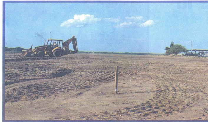
Última. La remoción de tierra en la zona del puerto privado está llegando a su etapa final.
