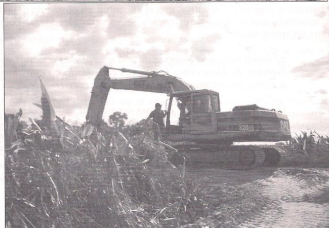
Construcción del terraplén
