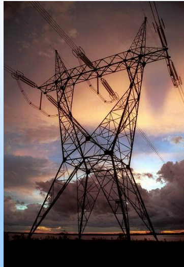
Generación de Energía
